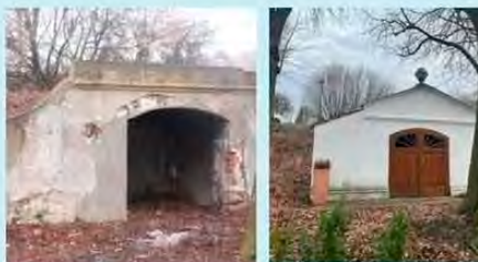
8, 9 - Kaple před a po rekonstrukci
