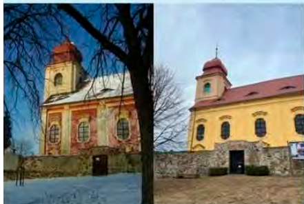
1, 2 - Kostel sv. Prokopa před a po rekonstrukci
