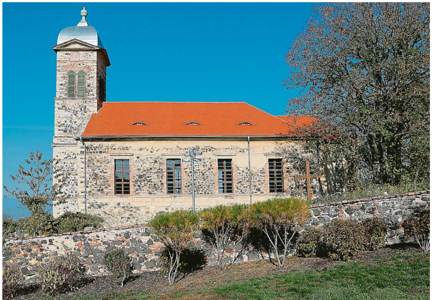
Kostel v Mrzlicích Postaven byl koncem 17. století, od roku 2013 prochází postupnou renovací. Naposledy se opravily schody na věž, díky čemuž na ni mohou vystoupat turisté. Věž nabízí zajímavý pohled na Mosteckou pánev a Krušné hory. Foto: Iveta Lhotská, MAFRA
